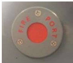
Feuerlöschöffnung auf der Backbordseite der Konsole
